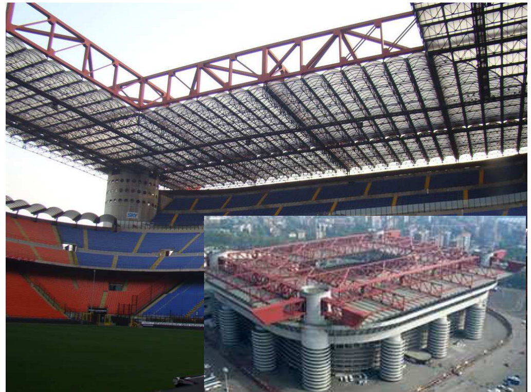
SVĐ San siro - Kết cấu dầm dàn
