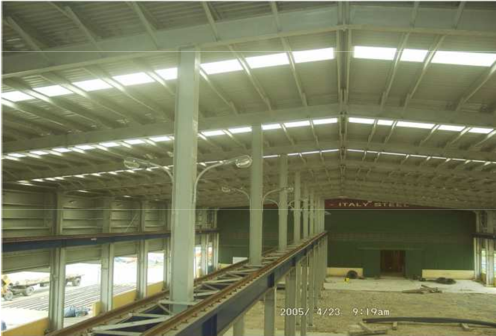
Hình ảnh dầm cầu trực và dàn hãm
