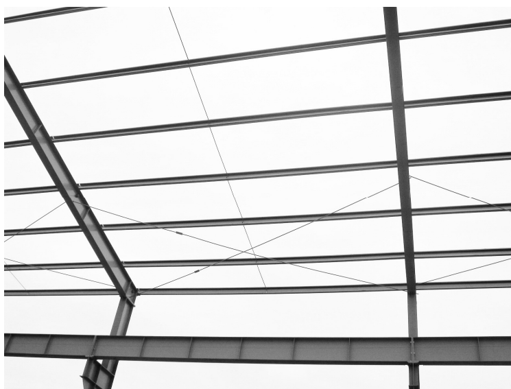
Hình 2.1 Giằng mái bằng thép tròn (1 thanh)
