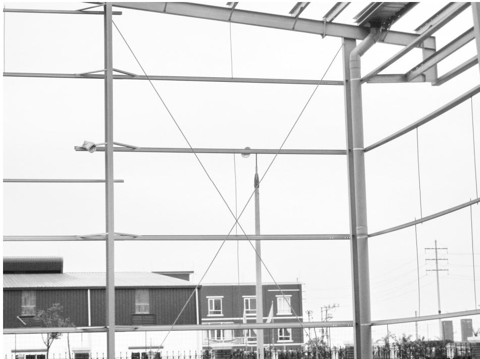
Hình 2.6 Giằng cột bằng thép tròn
