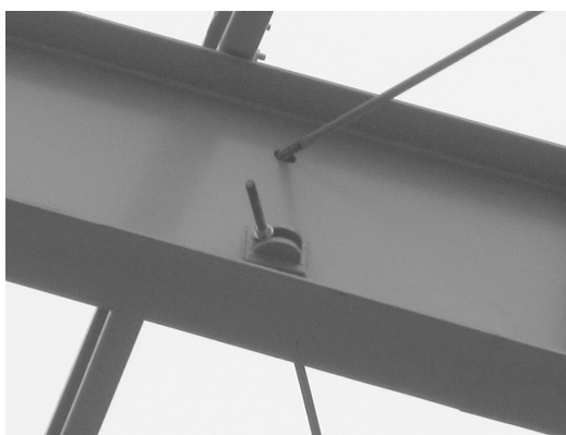
Hình 2.2 Liên kết giằng mái với xà ngang (trường hợp giằng bằng 1 thanh thép tròn)
