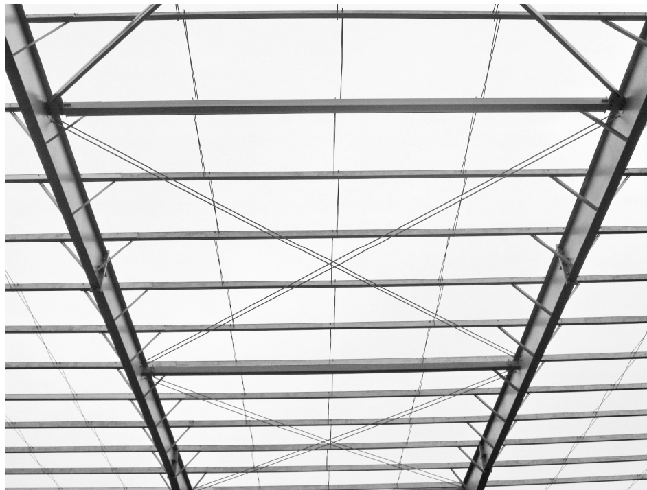
Hình 2.3 Giằng mái bằng thép tròn (2thanh)
