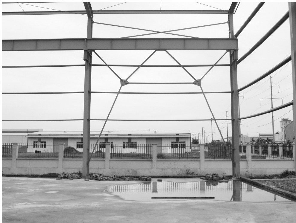
Hình 2.8 Giằng cột bằng thép góc đều cạnh (giằng dạng công)
