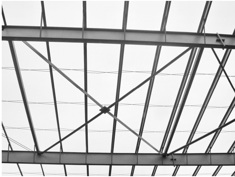
Hình 2.11 Giằng mái bằng thép góc đều cạnh (giằng chữ thập)
