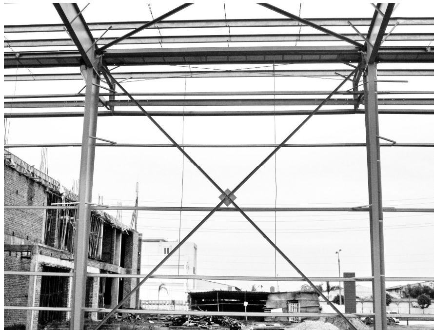
Hình 2.10 Giằng cột bằng thép góc đều cạnh (giằng chữ thập)
