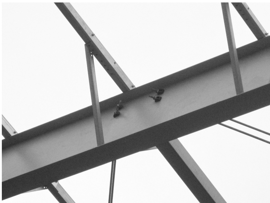
Hình 2.4 Liên kết giằng mái với xà ngang (trường hợp giằng bằng 2 thanh thép tròn)
